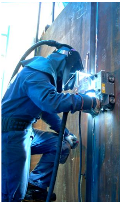
Verticaal in positie lassen
